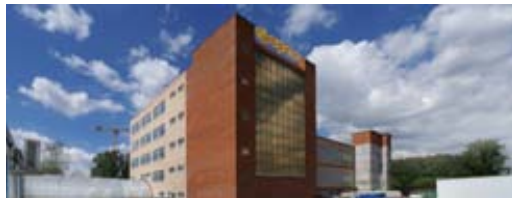
Um der Expansion gerecht zu werden, wird ein neues Firmengebäude gebaut
